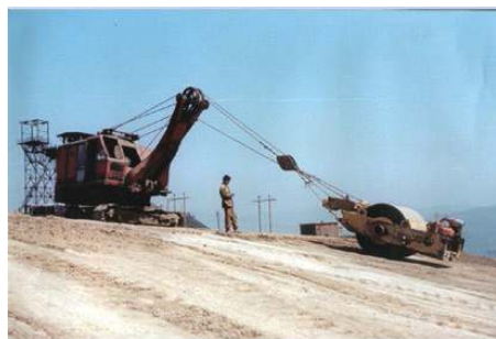
图6 覆盖碾压隔氧施工现场
