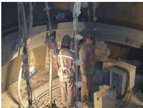
图 19 在内壁上安装竖向可缩装置施工图
