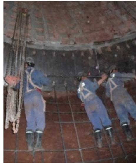
图 23 新型单层井壁施工图
