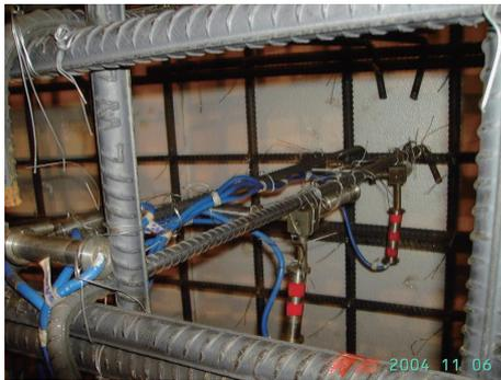
图 24 外层井壁内已安设的应变计实拍图
