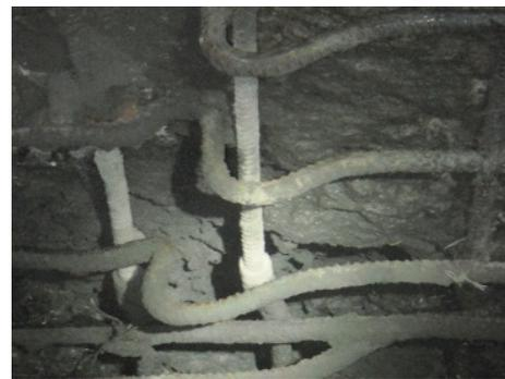
图 26 外壁破裂处环向钢筋弯曲情况实拍图
