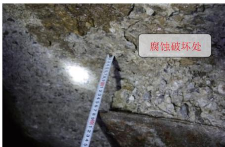
图 16 顺和煤矿副井井壁混凝土腐蚀实拍
