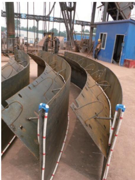
图 22 接茬钢板与注浆管实拍图
