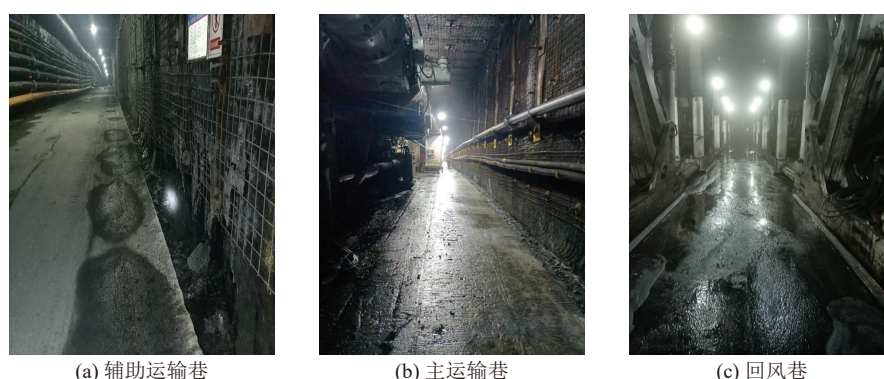
图21 超大断面巷道围岩变形控制效果
