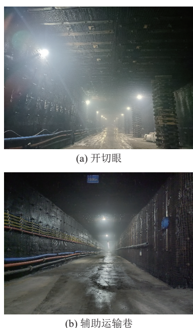
图 12 超大断面巷道掘进支护效果
