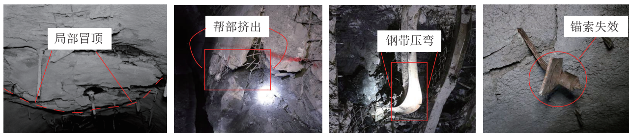
图3 巷道变形破坏
