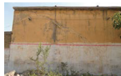
B05后墙斜裂缝
