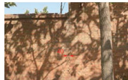
B01西侧院墙竖裂缝
