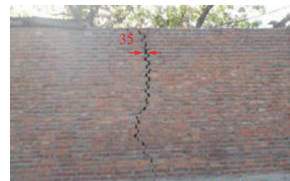
B03东侧院墙竖裂缝
