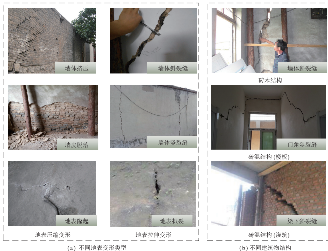
图 8 不同地表变形与结构对建筑物的影响
