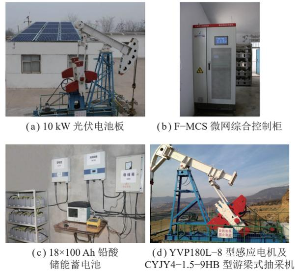
图 6 煤层气地面抽采直流微电网系统平台搭建
